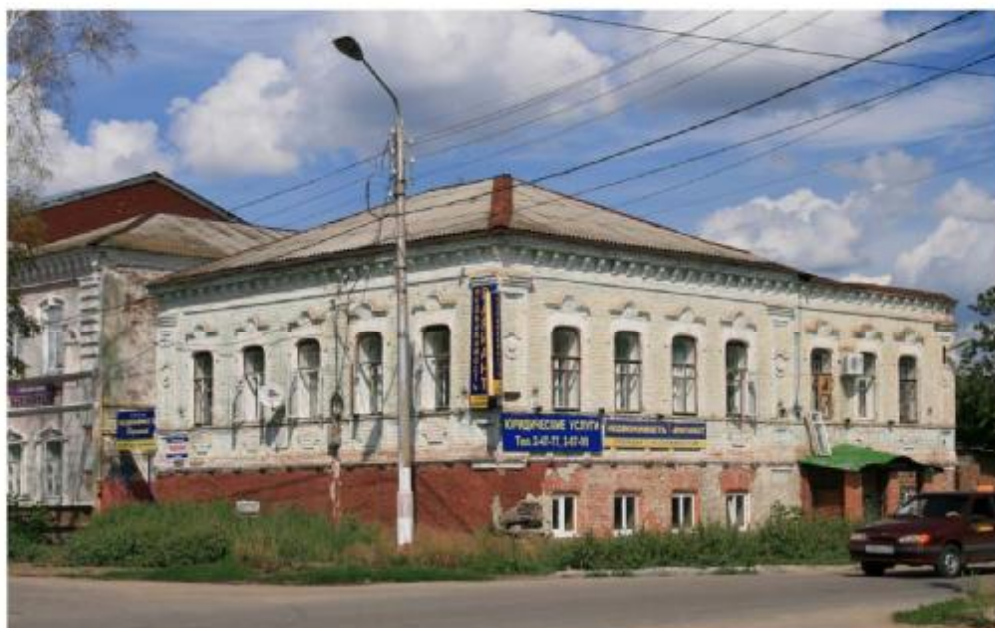
Рис.3. общий вид здания на момент постановки здания на государственную охрану и какой она оставалась до 2012 года.
