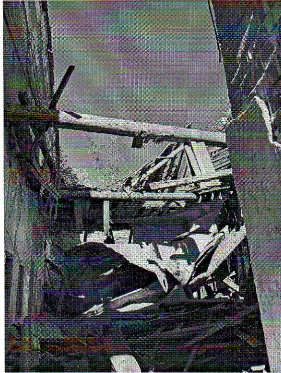
3 критерий «деформация перекрытий или их отсутствие»:
